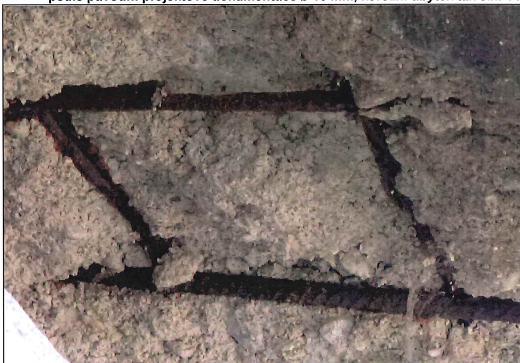
Obrázek 29 – detail výztuže, hloubková koroze a degradace betonu
