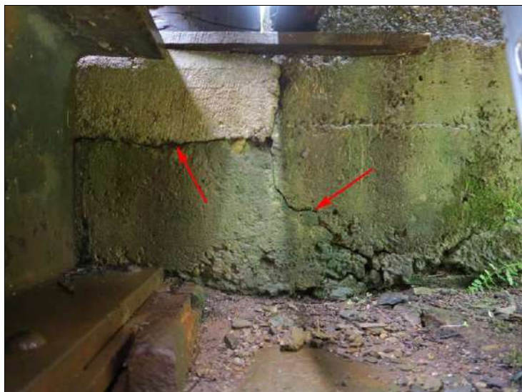
Foto. č. 4 – O 02, trhliny závěrné zdi vpravo.
