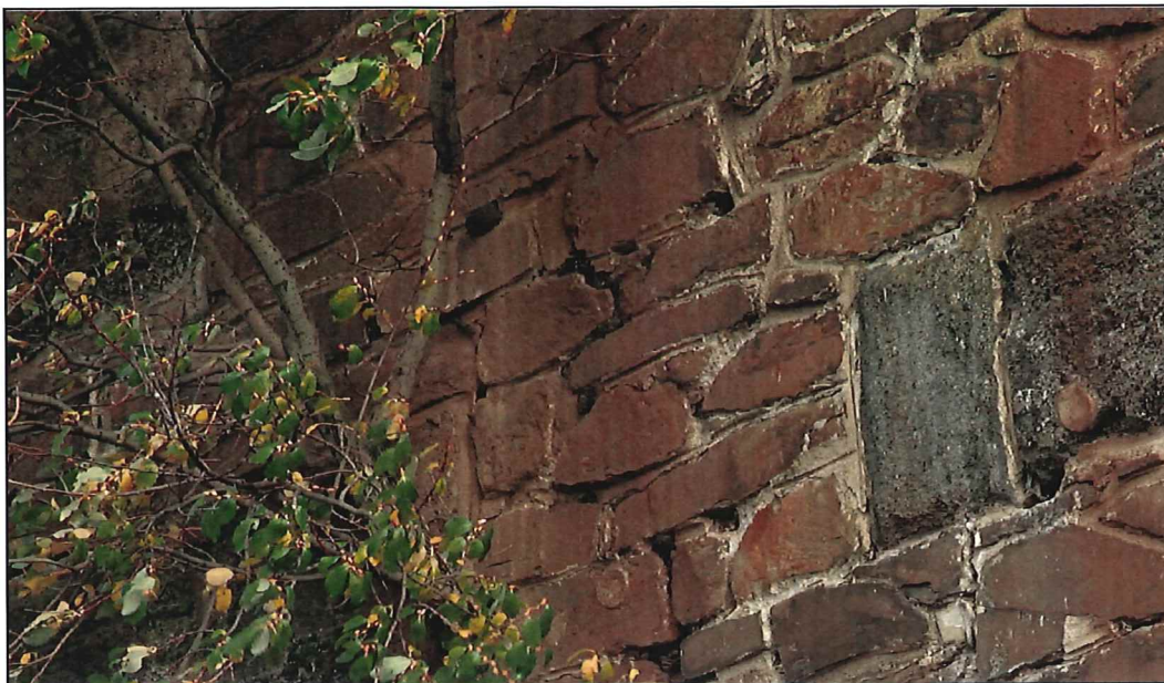
Obrázek 34 – opěra 02, vydrolené spáry ve zdivu, vegetace
