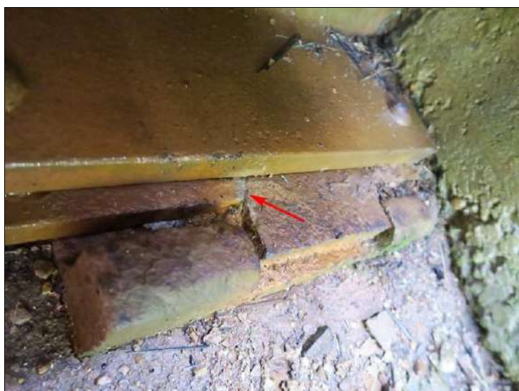
Foto. č. 2 – K 01, praská nadložisková deska ložiska na O 02 vpravo.
