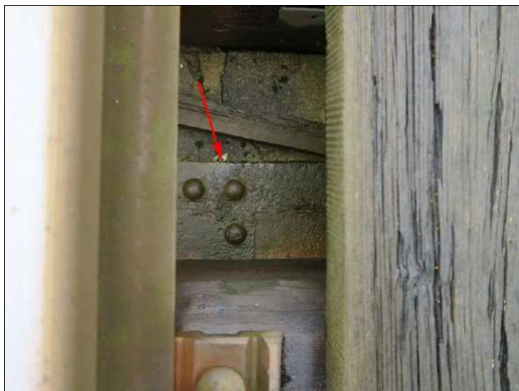
Foto. č. 1 – K 01, zapření pravého nosníku do závěrné zdi O 02.
