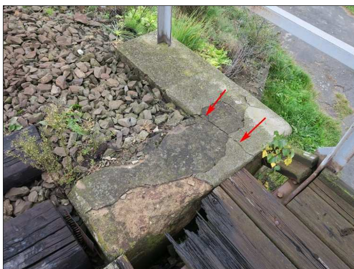
Foto. č. 3 – O 02, stupňovitá trhлина ve spáře ve střední, horní části opěry.
