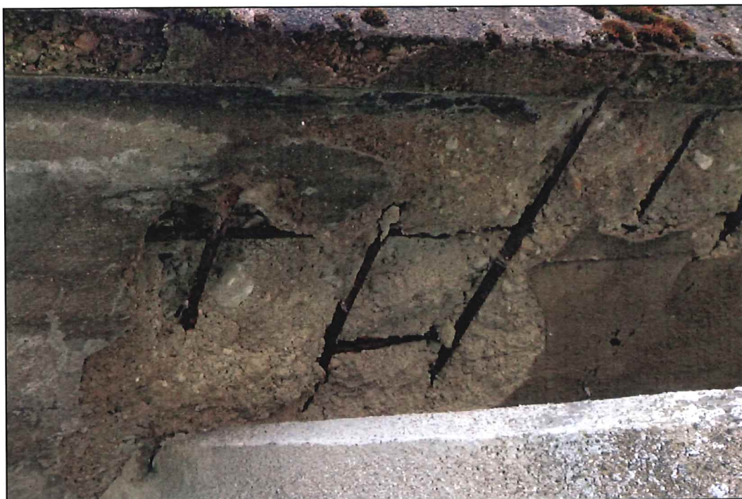
Obrázek 26 – Sonda N1 - levá římsa na O 01, odsekaná krycí vrstva, krytí 20 mm
