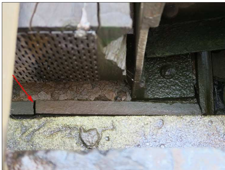
Foto. č. 1 – K 01, prasklé ložisko a oslabené dolní úhelníky hlavního nosníku vlevo na O 02.
