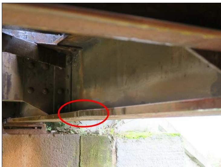
Foto. č. 1 – K 01, deformace levého hlavního nosníku.
