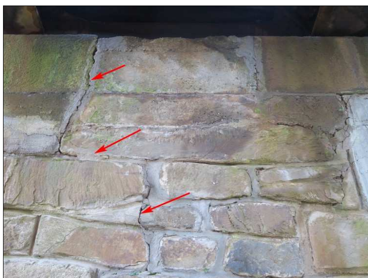
Foto. č. 3 – O 02, stupňovitá trhlina ve spáře ve střední, horní části opěry.
