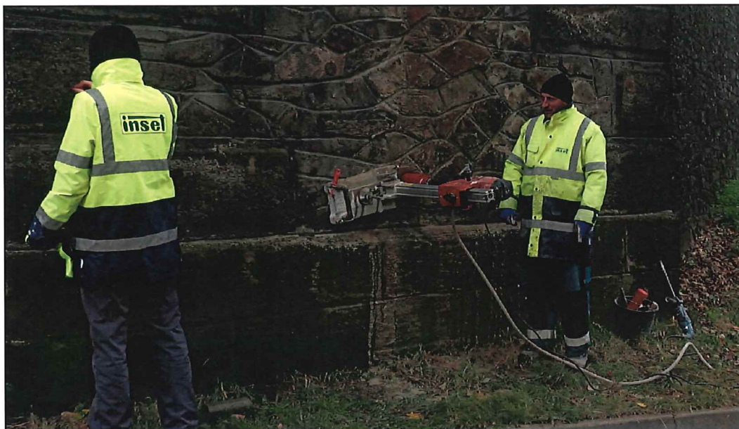
Obrázek 6 - lokalizace vrtu VS1 na opěře O 01
