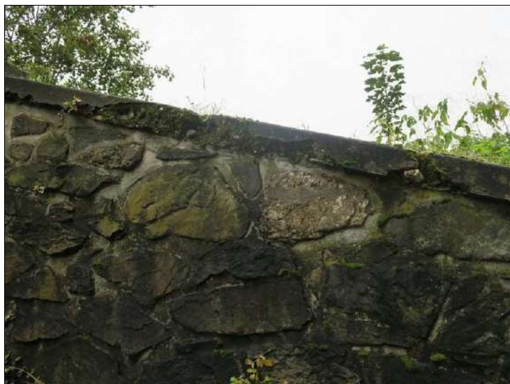
Foto. č. 5 – O 02, křídlo vpravo, silná degradace římsy křídla.
