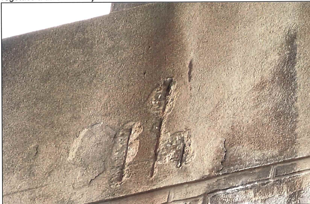
Obrázek 30 - opěra 01, čelní líc úložného prahu, obnažená výztuž
