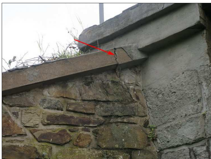
Foto. č. 2 – O 01, křídlo vpravo - trhlina v římse křídla.
